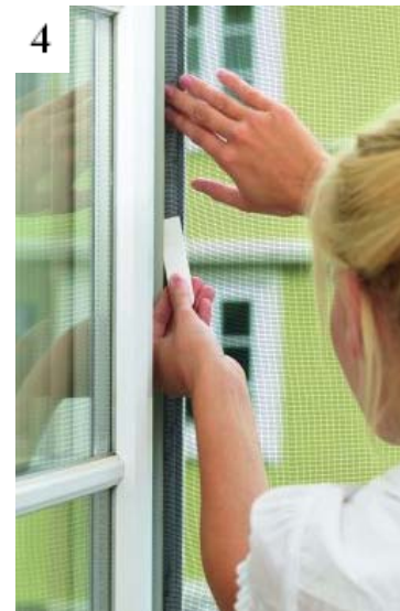
Dokładnie docisnąć siatkę do rzepu za pomocą szczoteczki
